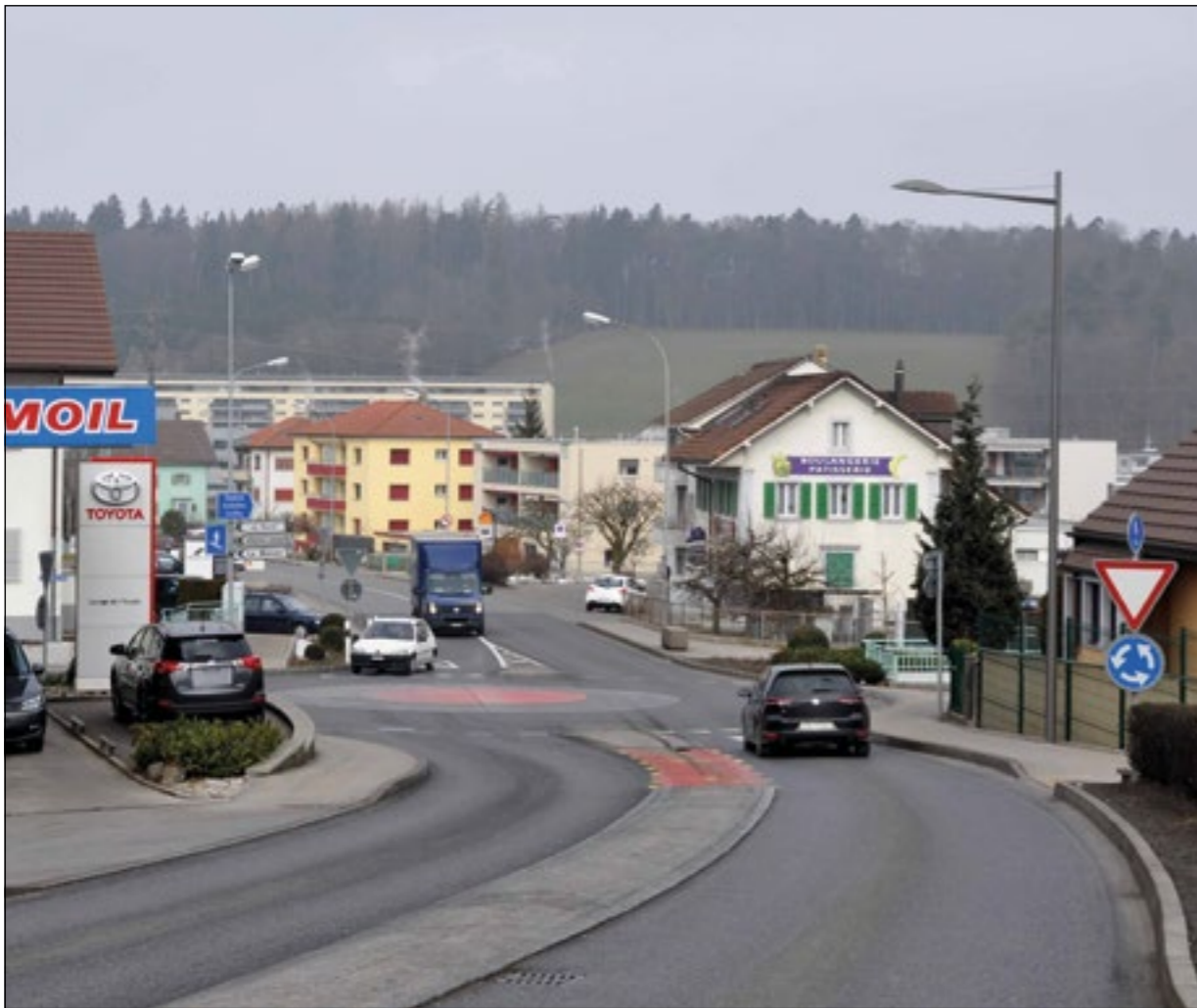
Vue de la route de Belfaux, lien entre le noyau historique et la future halte ferroviaire (Image : Georges Baechler)
